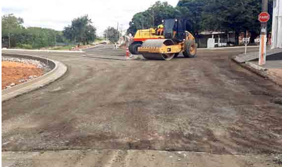
Obras exigirão uma atenção maior dos motoristas
