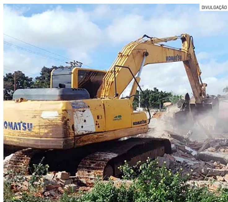
Empresário iniciou os preparativos para a etapa de colocação de estacas, bem como sondagem e preparação do terreno
