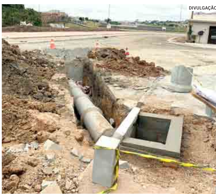
Em alguns trechos, são implantados grandes tubos de concreto para captação de águas das chuvas
