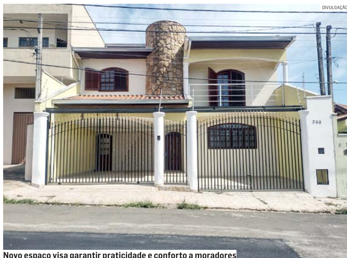
Novo espaço visa garantir praticidade e conforto a moradores
