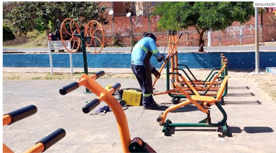
Aparelhos instalados em três bairros recebem reparos e manutenção
