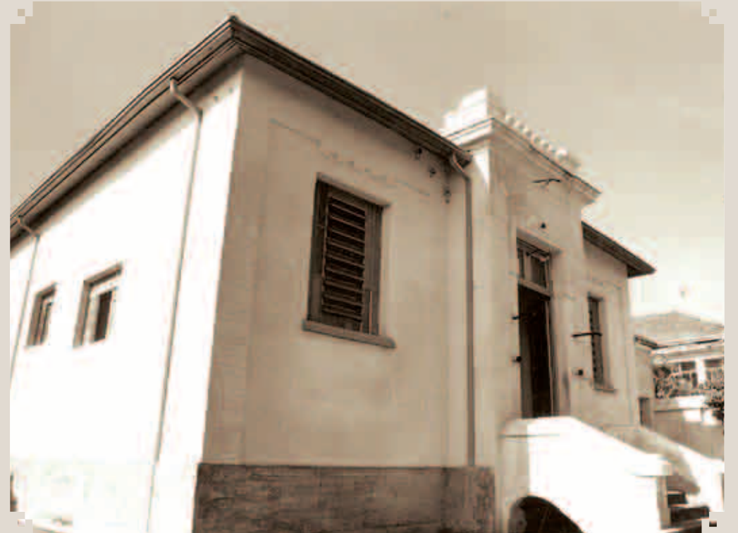
Foto do antigo Posto Policial de Sumaré, construído no início da década de 1920, na esquina da Praça da República com a rua Antônio do Valle Mello. No governo de Paulo Célio Moranza o prédio foi utilizado como CIRETRAN. Na década de 2000 foi restaurado pela empresa SOTREQ e hoje é utilizado pela Prefeitura como uma de suas secretarias.
