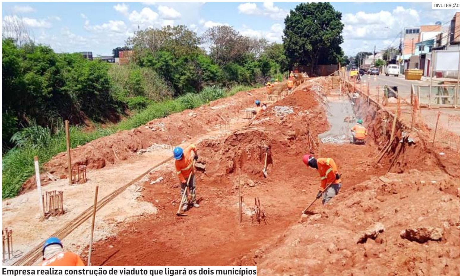
Empresa realiza construção de viaduto que ligará os dois municípios
