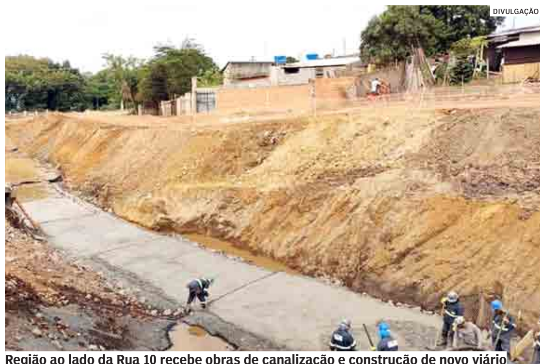
Região ao lado da Rua 10 recebe obras de canalização e construção de novo viário
