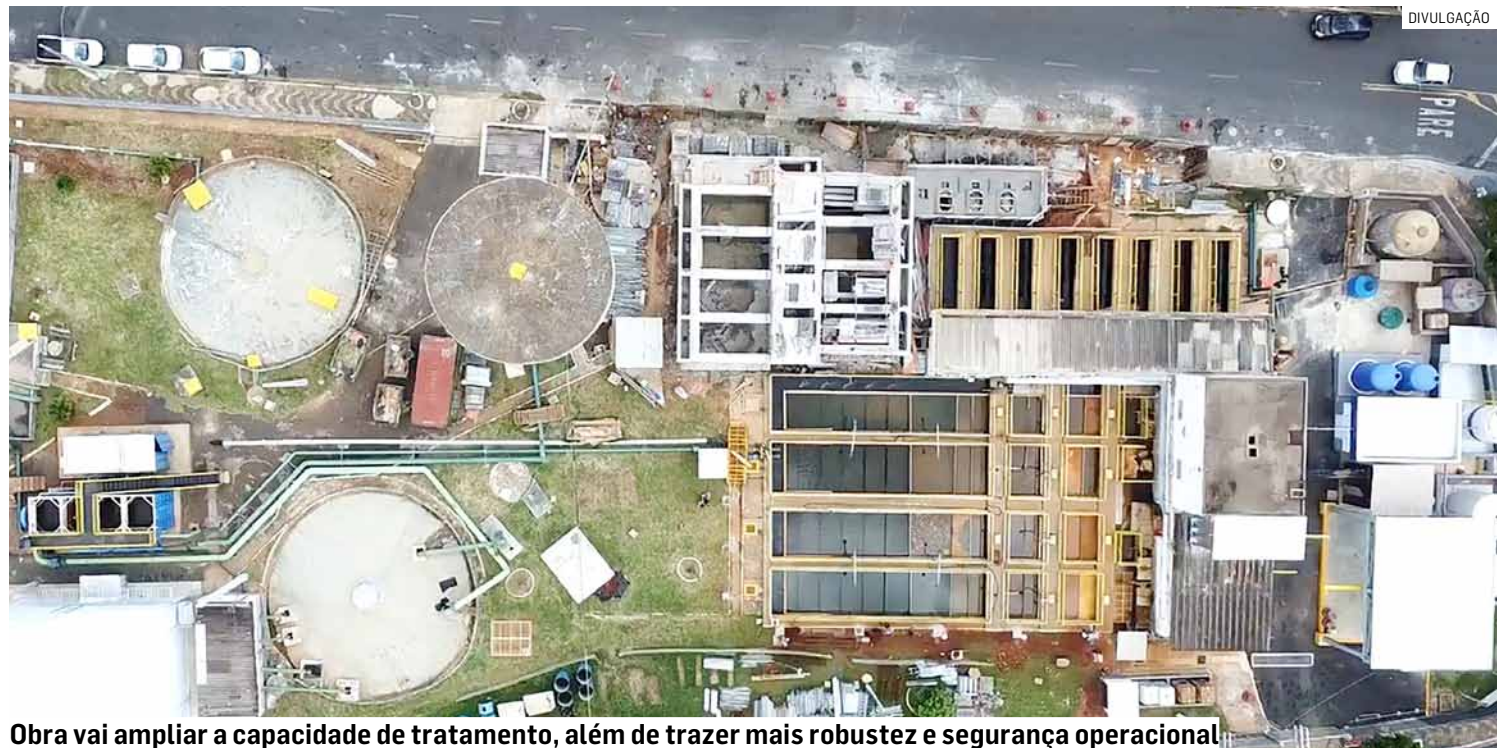
Obra vai ampliar a capacidade de tratamento, além de trazer mais robustez e segurança operacional
