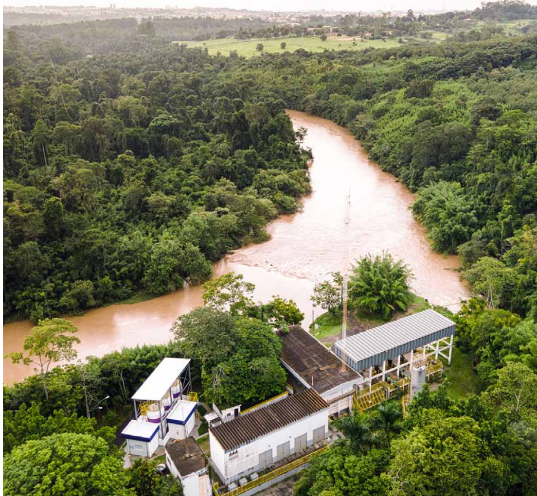
Rio Piracicaba está com a vazão abaixo da média histórica devido a estiagem prolongada
