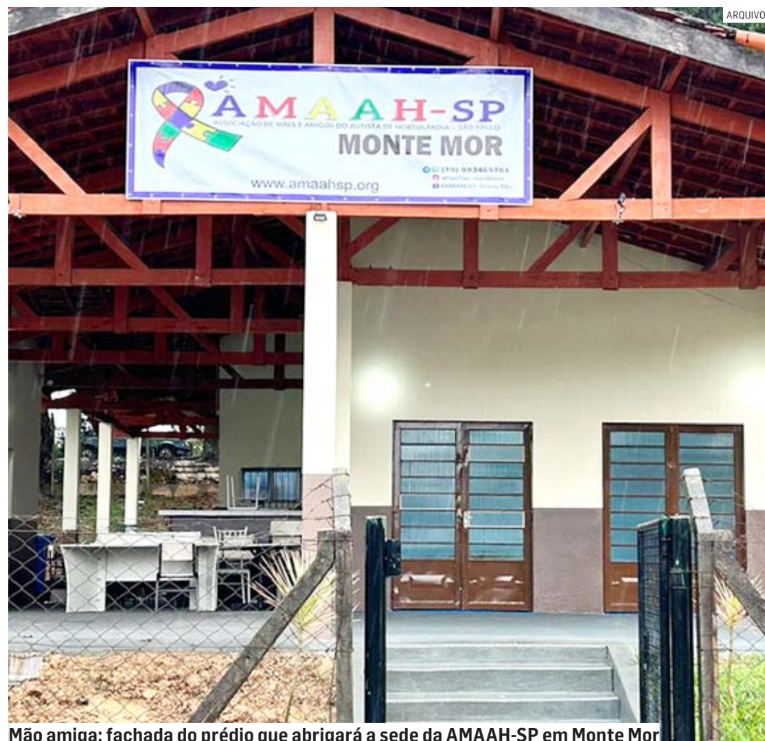
Mão amiga: fachada do prédio que abrigará a sede da AMAAH-SP em Monte Mor
