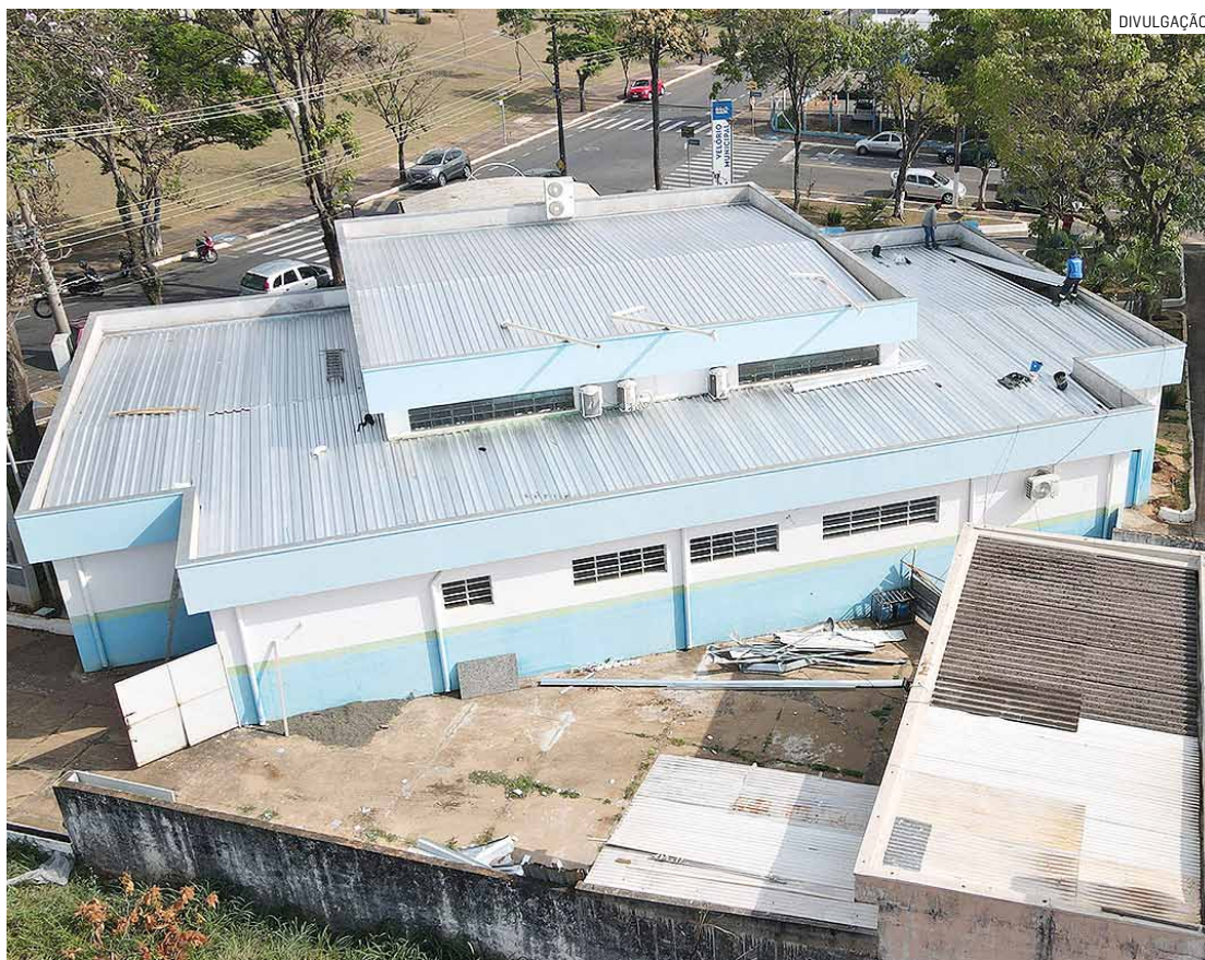
Obra corrigiu falhas de reformas anteriores, garantindo segurança e funcionalidade do espaço
