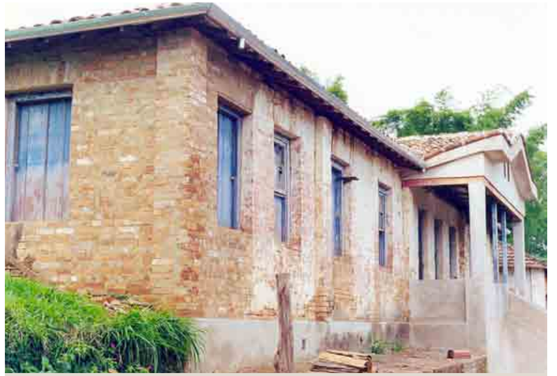
Casarão Fazenda Sertãozinho durante a reforma
