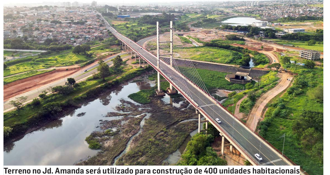
Terreno no Jd. Amanda será utilizado para construção de 400 unidades habitacionais
