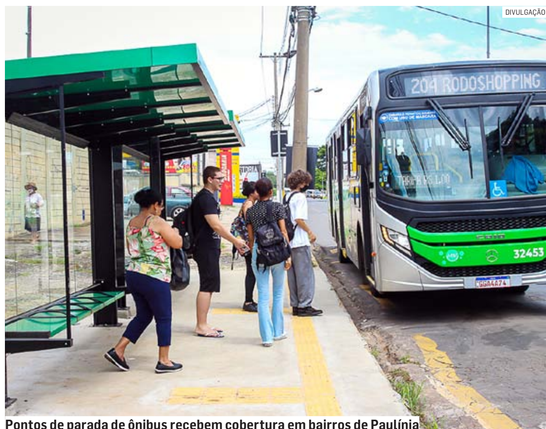
Pontos de parada de ônibus recebem cobertura em bairros de Paulínia
