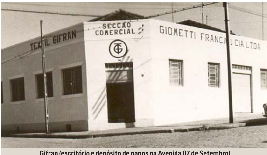
Gifran (escritório e depósito de panos na Avenida 07 de Setembro)
