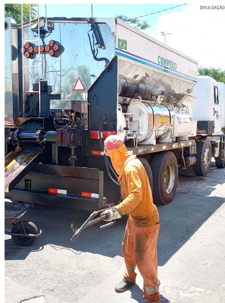
Novo maquinário agiliza serviços de recuperação do asfalto
