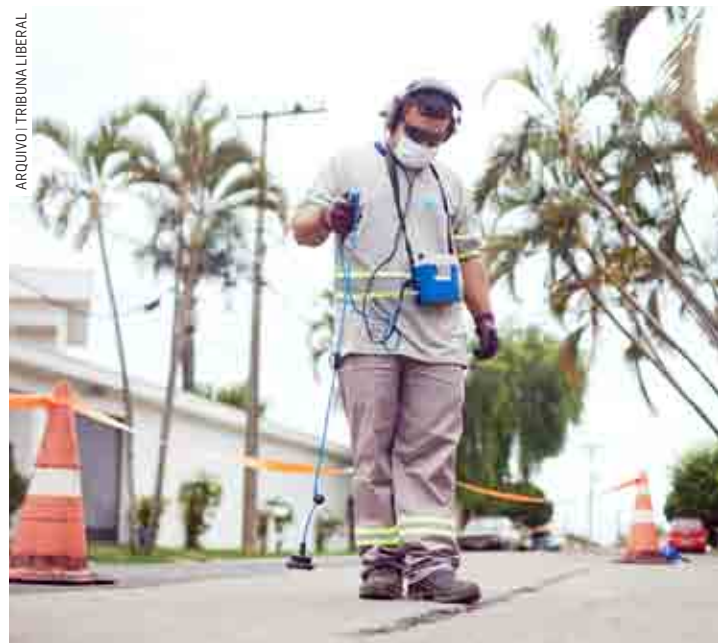
Troca é feita após trabalho de hasteamento das ligações
