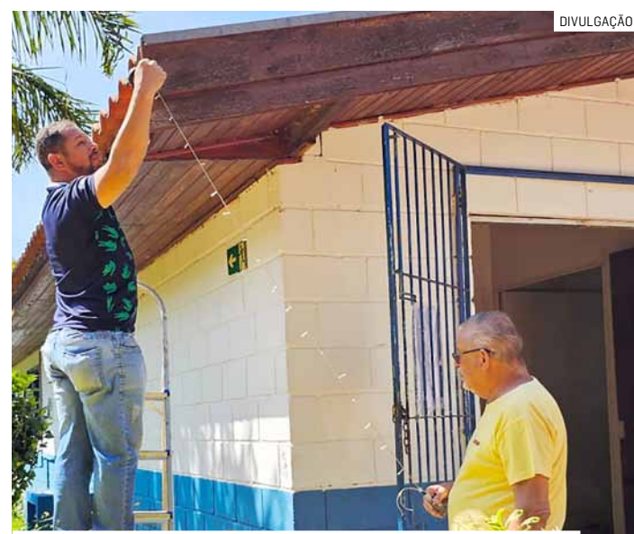
Centenas de microlâmpadas estão sendo instaladas, no madeiramento e em estruturas metálicas do parque
