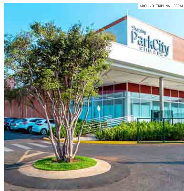
Estrutura que será montada no estacionamento do shopping
