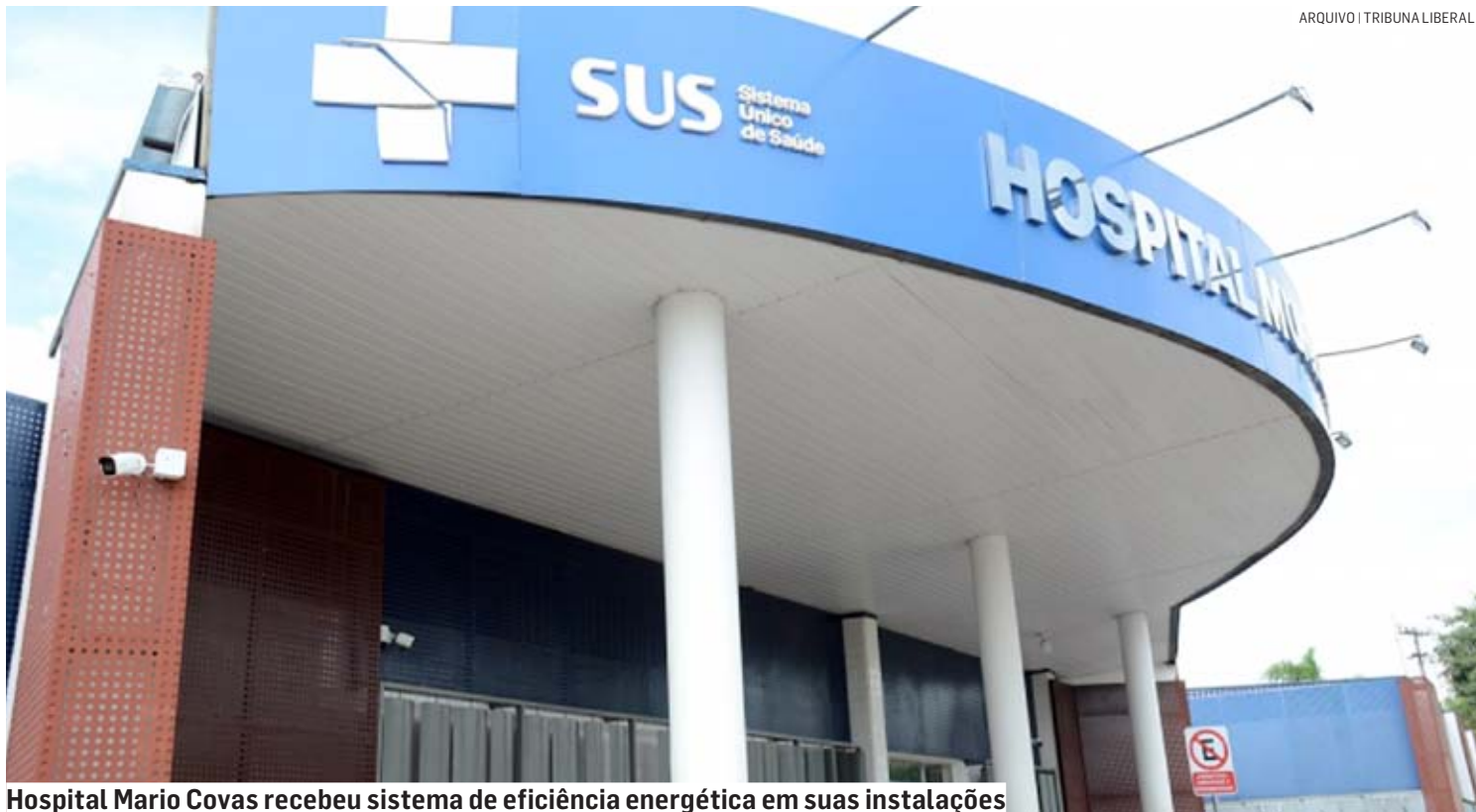
Hospital Mario Covas recebeu sistema de eficiência energética em suas instalações
