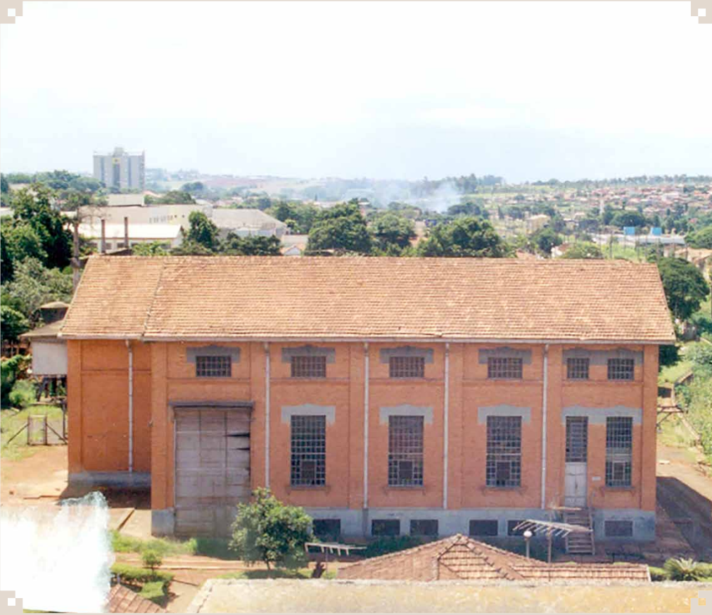
Foto da década de 2000, tirada do alto do antigo Moinho Universal, da Subestação de energia elétrica da Companhia Paulista de Estradas de Ferro. O prédio é tombado pelo CONDEPHAAT e CONDEPHAEA.
