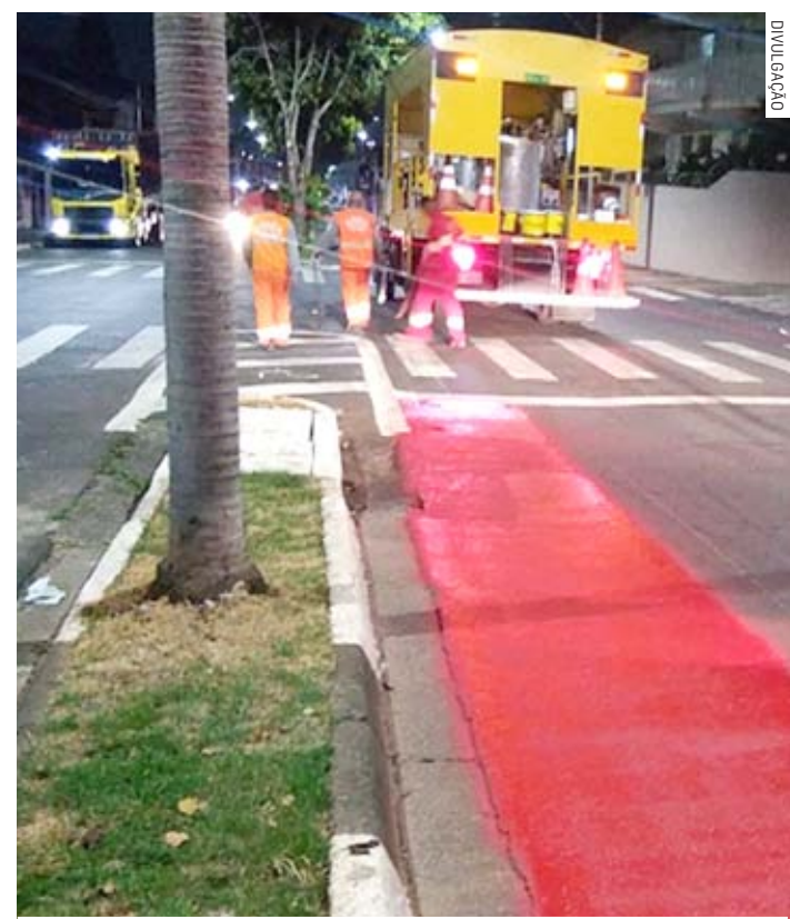
Pintura é realizada na ciclofaixa da avenida Cora Coralina
