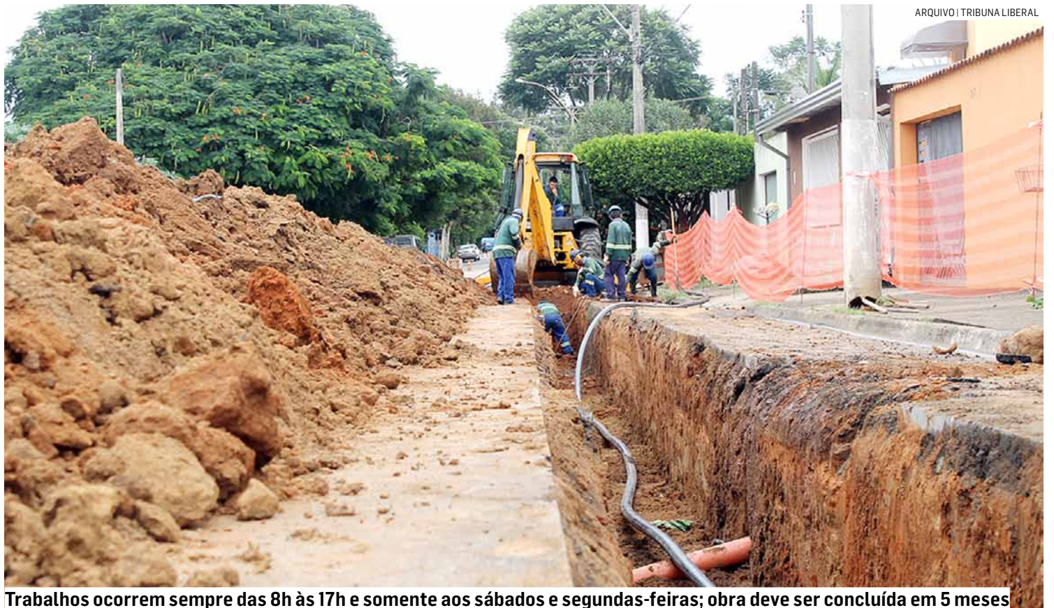
Trabalhos ocorrem sempre das 8h às 17h e somente aos sábados e segundas-feiras; obra deve ser concluída em 5 meses
