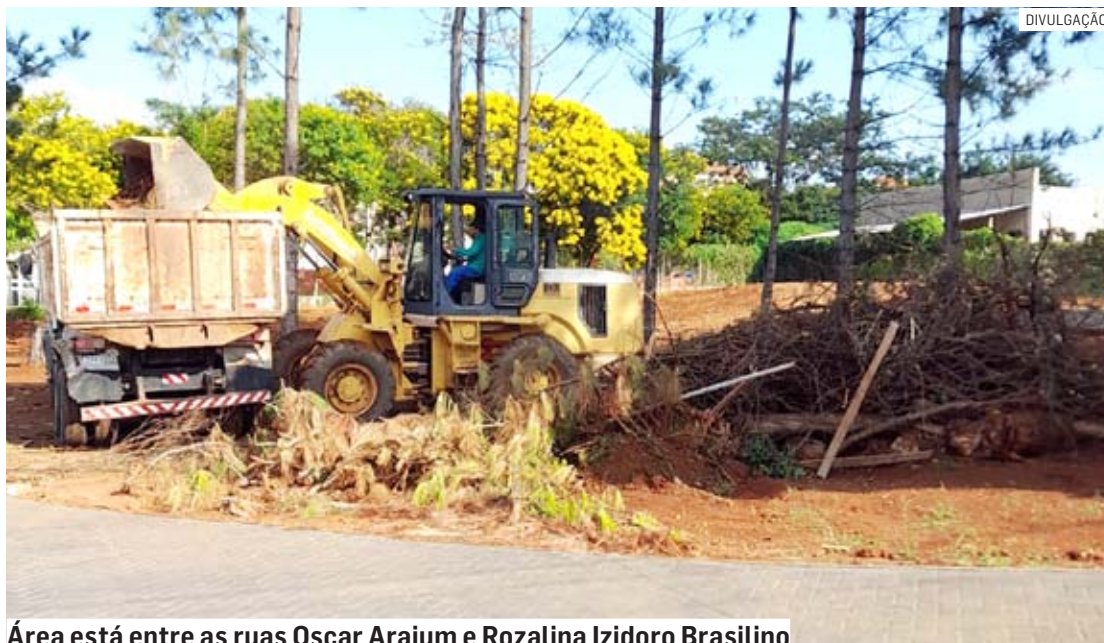
Área está entre as ruas Oscar Araiun e Rozalina Izidoro Brasilino
