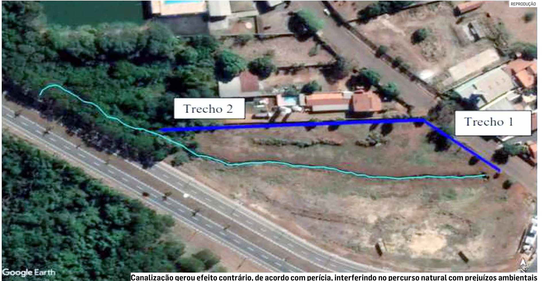
Canalização gerou efeito contrário, de acordo com perícia, interferindo no percurso natural com prejuízos ambientais
