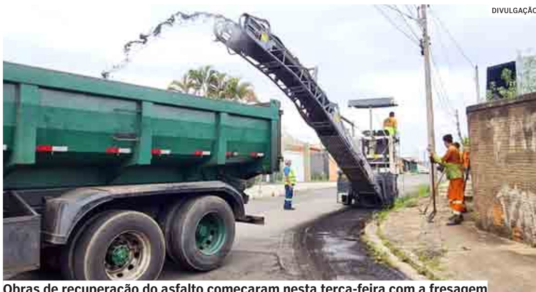
Obras de recuperação do asfalto começaram nesta terça-feira com a fresagem
